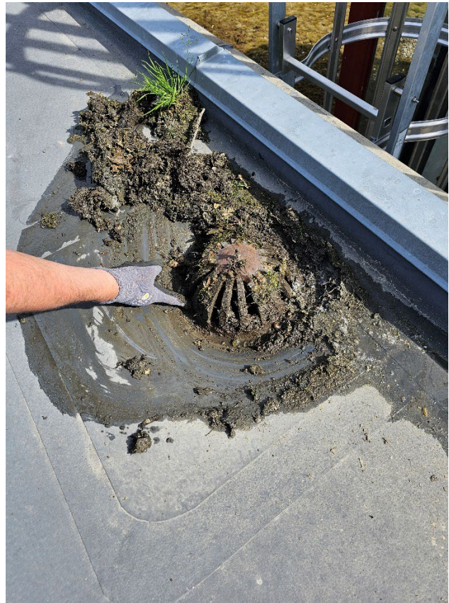
Bilde 2:.. etter fjerning av gresset kommer sluken til syne [Foto: NTNU]
