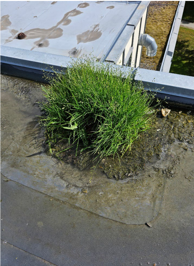
Bilde 1: Gress som tetter igjen sluk... [Foto: NTNU]
