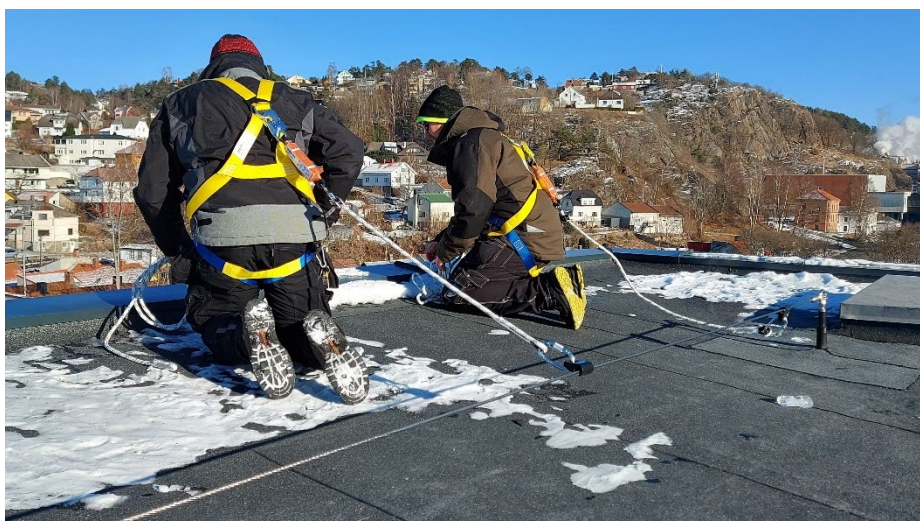
Figur 3: Samtidig sikring av flere brukere. Foto: Fallsikkerhet.no AS
