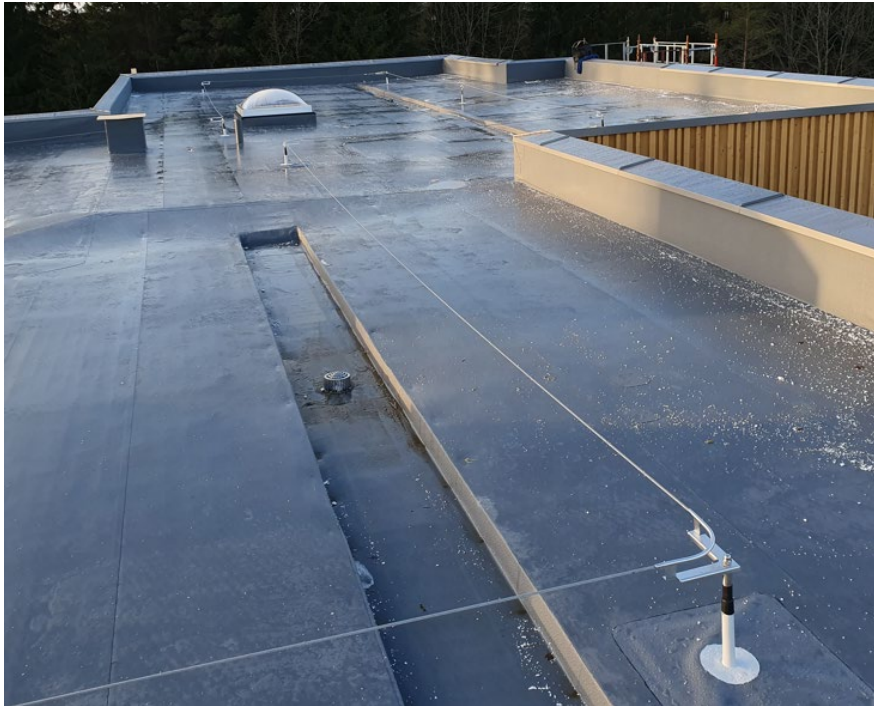
Figur 1: Fallsikringssystem for personlig fallsikringsutstyr på flatt tak. Foto: Fallsikkerhet.no AS
