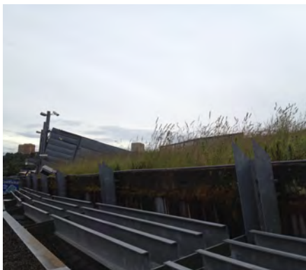
Nedre kant, med stålkonstruksjon, utenfor
