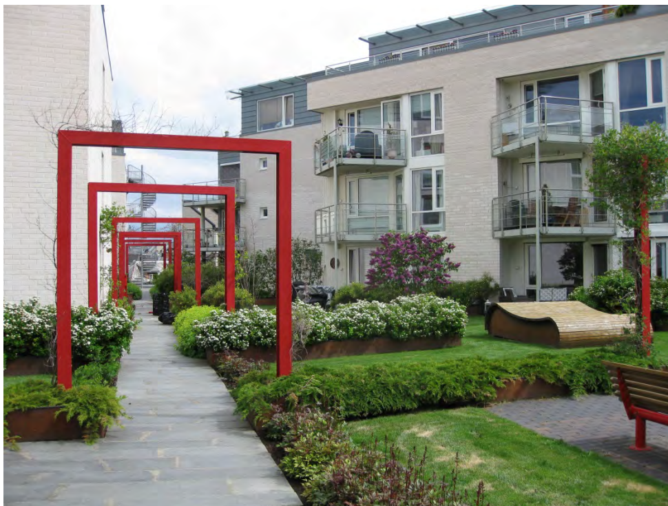
Figur 3.6. Eksempel på intensivt grønt tak med varierende vekstlagstykkelse i forhold til behovene til beplantningen. Foto: SINTEF Byggforsk
