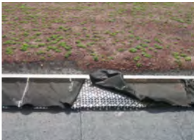
Oppbygging av sedumdekket oppå asfoltakbelegget, «nysådd». Foto: Gåså ark.
