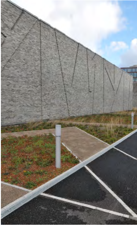
Figur 3.3. Eksempel på semi-intensivt grønt tak. Foto: UMB/ILP
