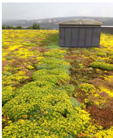
Striper av sedum over renner Foto: ILP/UMB
