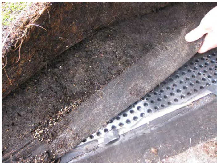
Oppbygningen av sedumtaket. Foto: SINTEF Byggforsk
