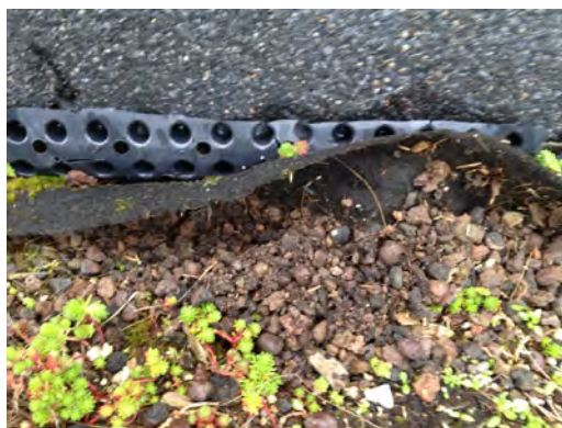
Oppbygging m knåsteplate, filtduk og lavastein og lett-klinker. Foto: ILP/UMB
