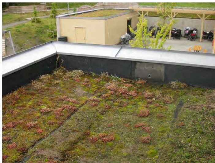
Parapet med nødoverløp. Foto: SINTEF Byggforsk
