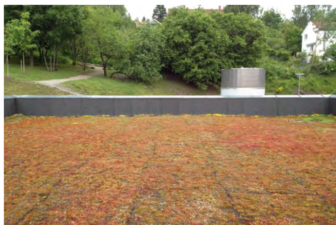
Utsyn over sedumtaket, juni 2012. Foto: ILP/UMB
