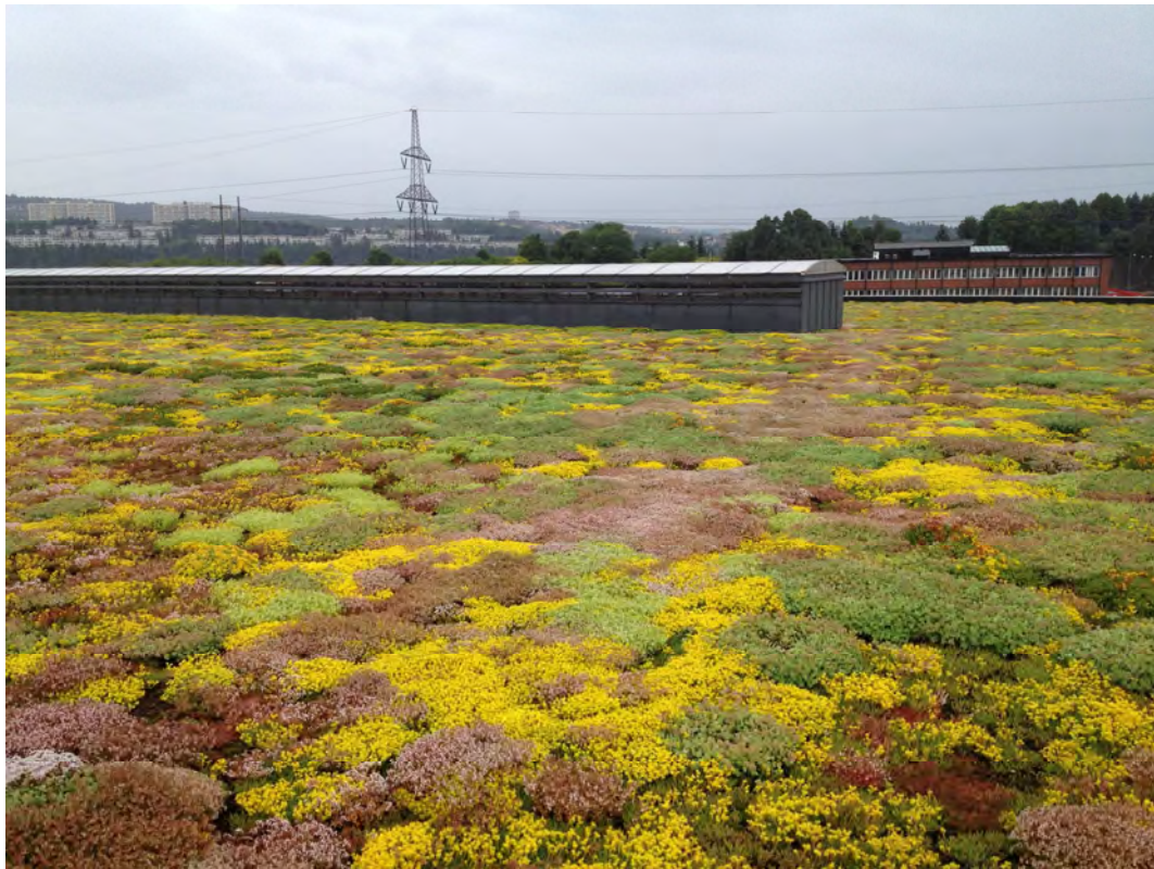
Figur 3.2. Eksempel på ekstensivt tak, sedumtak. Foto: UMB
