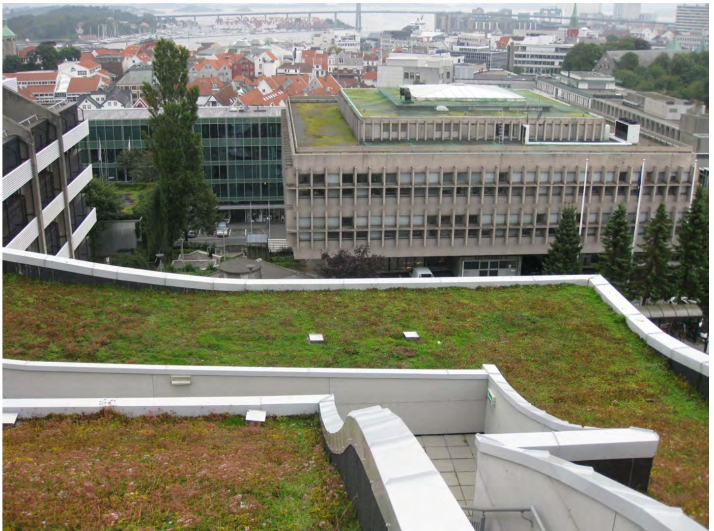
Gangarealer brukt som nødutganger. Foto: SINTEF Byggforsk
