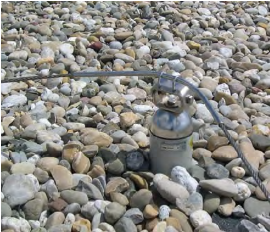
Figur 4.7. Eksempel på festepunkt for sikkerhetsline. Sikkerhetsselelen hektes på wren med en spesiell låsemekanisme og som kan gli langs wren. (Foto: SINTEF Byggforsk)
