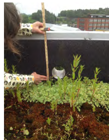
Parapet med nødoverløp Foto: ILP/UMB
