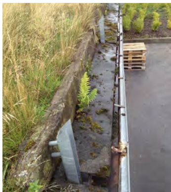
Nedre kant med torvholdestokk.
