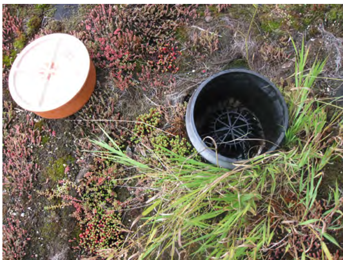
Sluk med inspeksjonsbrønn. Foto: SINTEF Byggforsk
