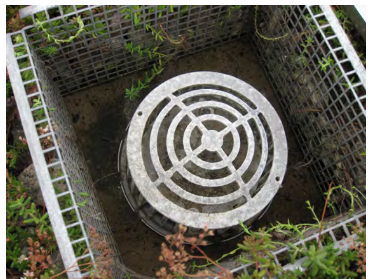
Sluk med inspeksjonsbrønn. Foto: SINTEF Byggforsk
